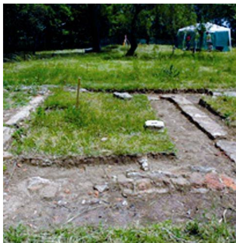
Restos del Vesubio luego de su demolición
